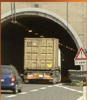
Weil hier testen verboten ist, untersucht das Testteam vier Tunnel im Großraum Genua mit einem unauffälligen Mietwagen. Der "Rocco Carpanea" (zwei Röhren) hat eine relativ gute Beleuchtung und Fahrbahnausstattung. In der Tunnelmitte findet sich ein ungekennzeichneter und unverschlossener Notübergang zur anderen Röhre. Im Brandfall kann hier Rauch aus der Brandröhre hineingelangen.
